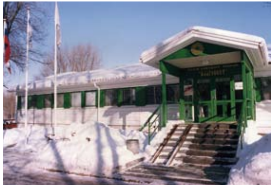
Hovedindgang til Center for Folkehjælp, Blagovest. Bygningen blev opført af ASF-Dansk Folkehjælp
